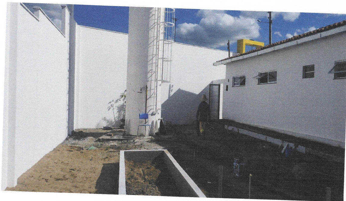
FOTO 03 EXECUÇÃO DE PINTURA EXTERNA
