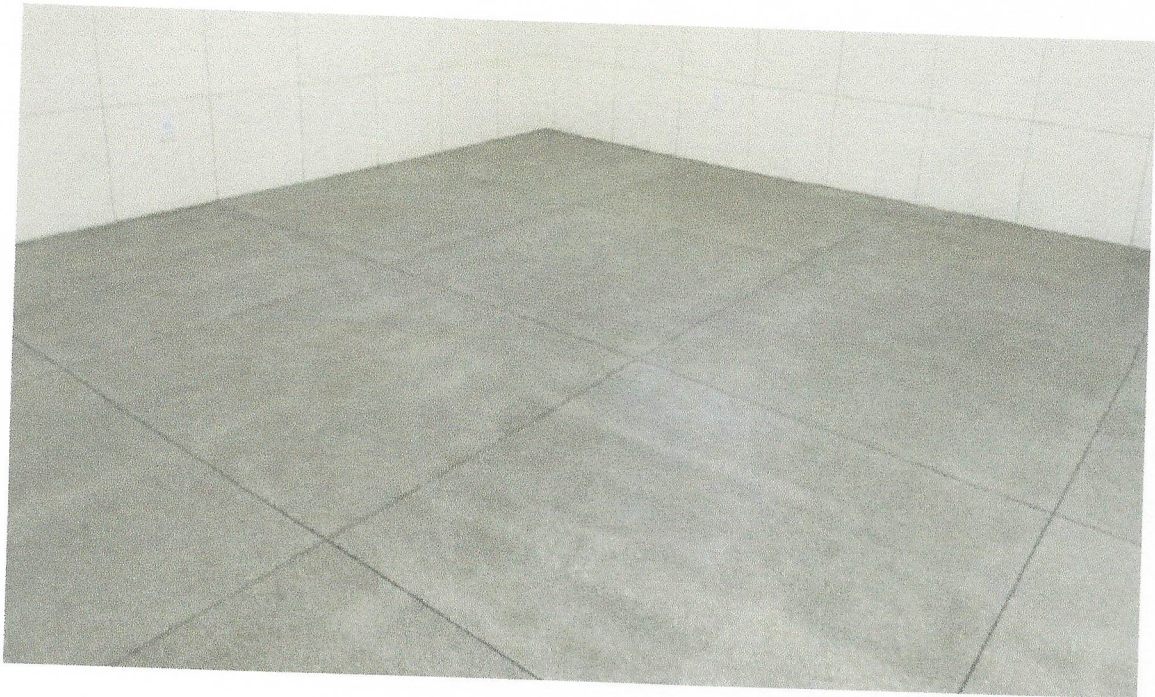
FOTO 11 LIMPEZA FINAL DE OBRA
