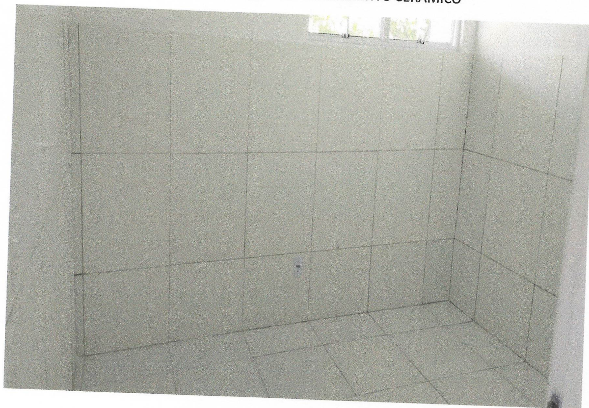
FOTO 08 EXECUÇÃO DE REVESTIMENTO CERAMICO
