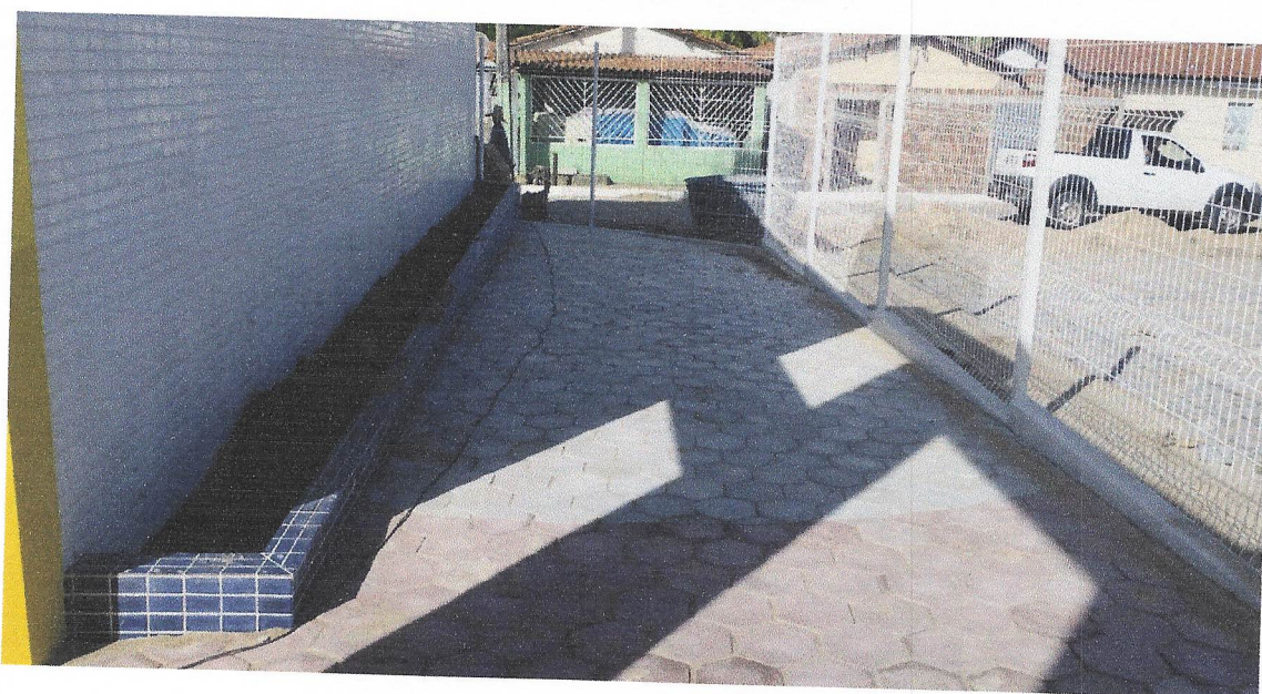
FOTO 06 EXECUÇÃO DE PISO INTERTRAVADO
