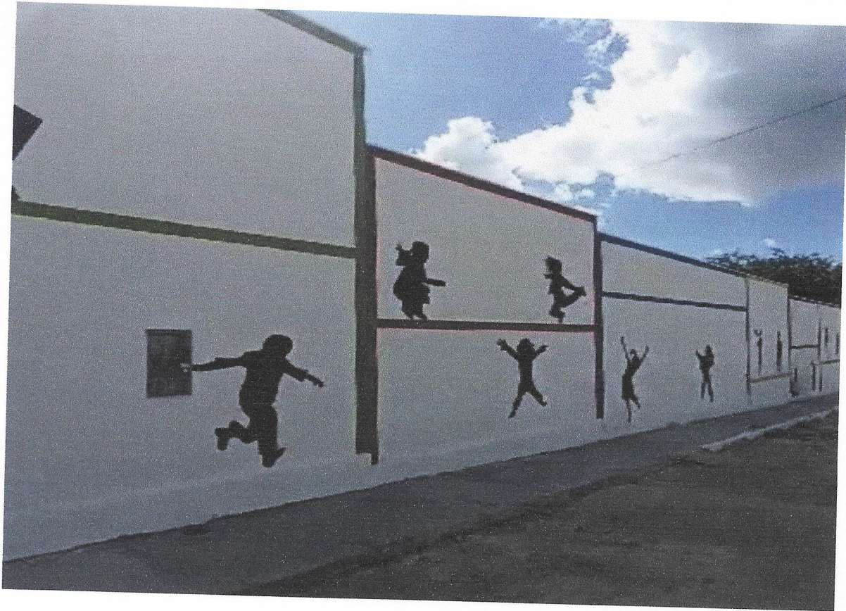
FOTO 25 PINTURA EXECUÇÃO DE ARTE NA PINTURA DO MURO EXTERNO
