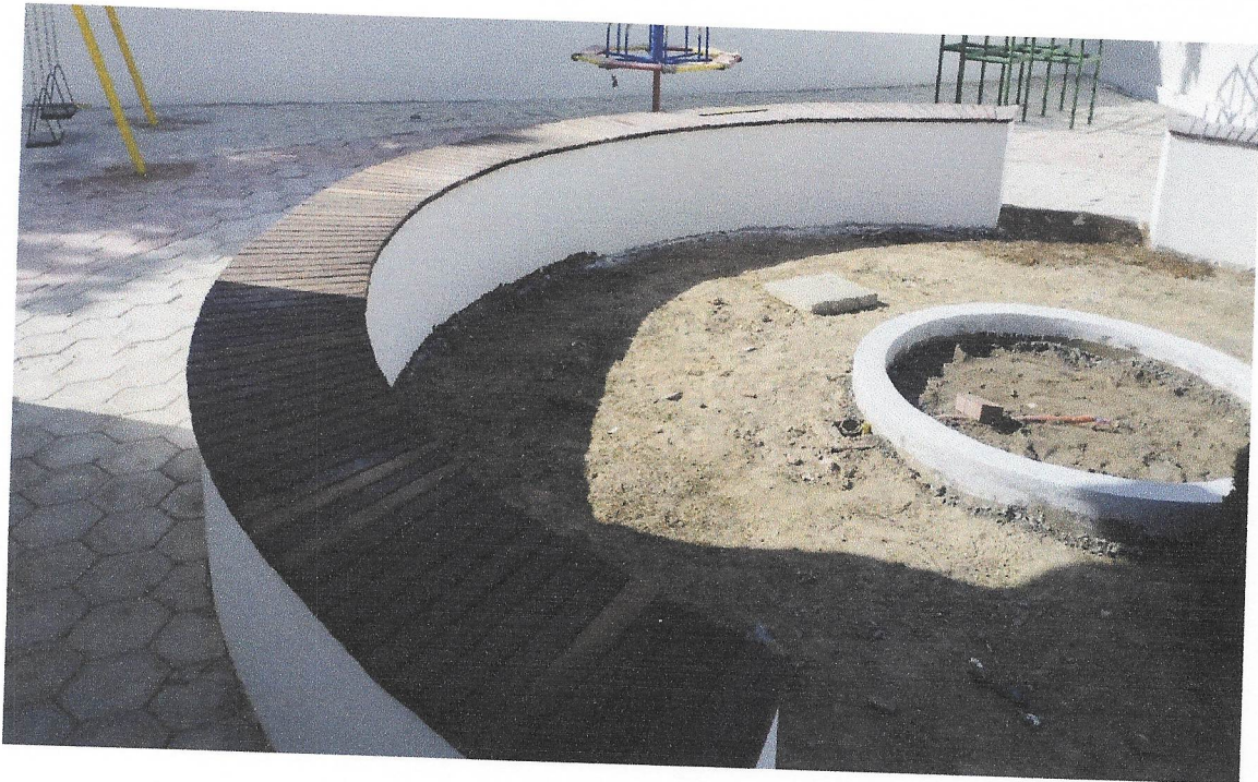
FOTO 09 EXECUÇÃO DE REVESTIMENTO EM MADEIRA EM CIMA DOS BANCOS
