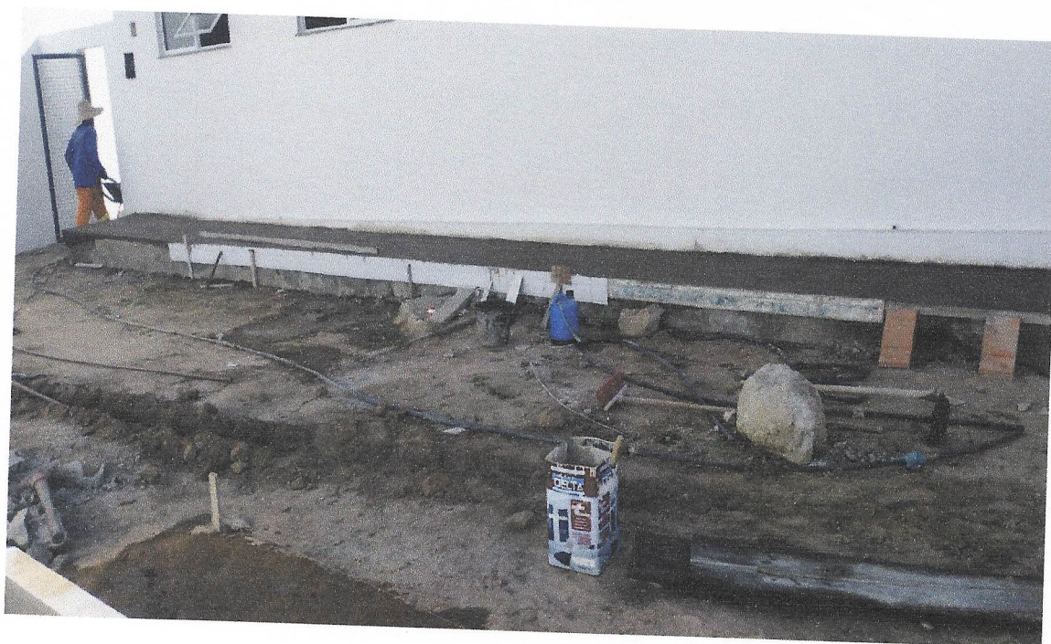
FOTO 04 EXECUÇÃO DE PASSEIO
