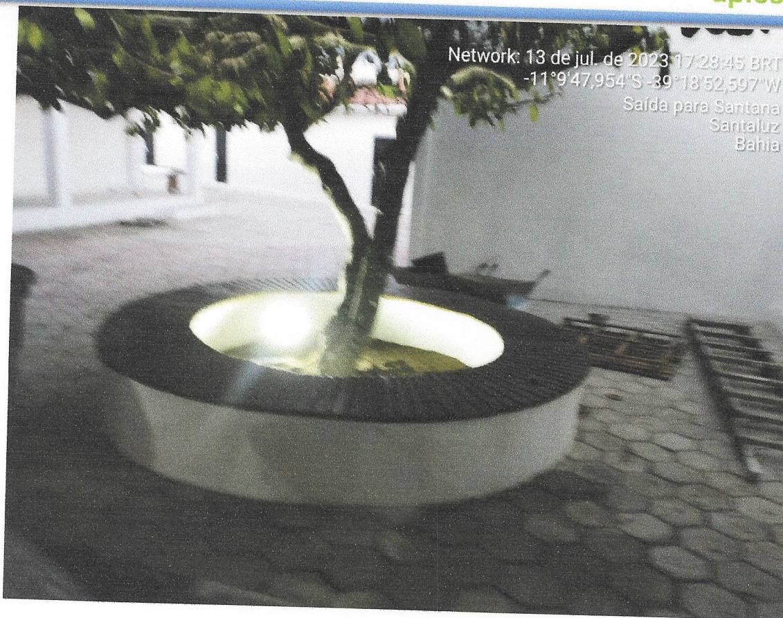
FOTO 15 instalação de refletor nos canteiros
