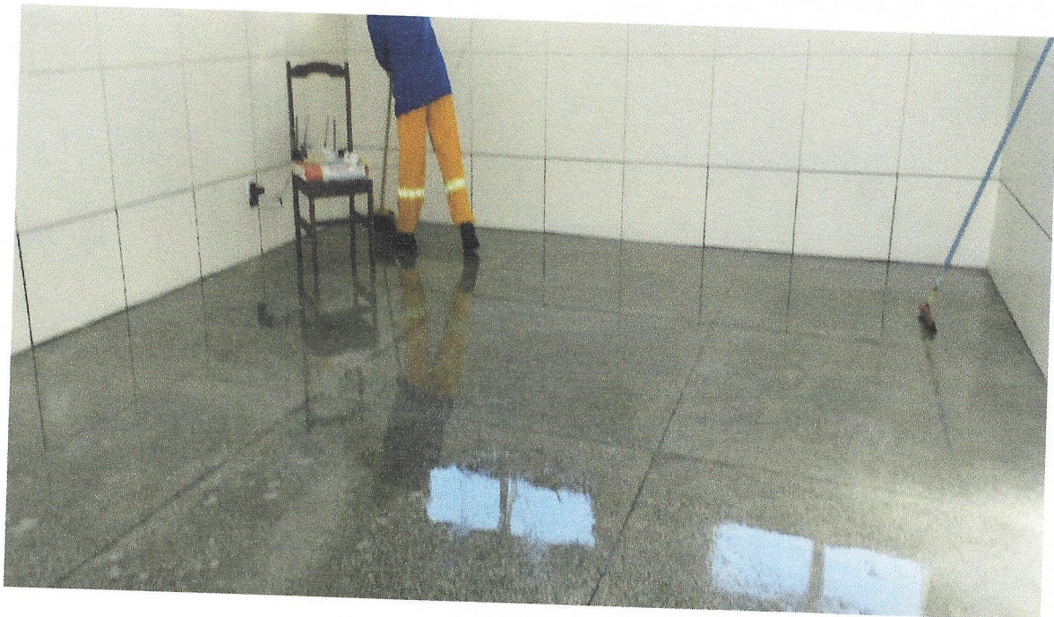
FOTO 10 LIMPEZA FINAL DA OBRA
