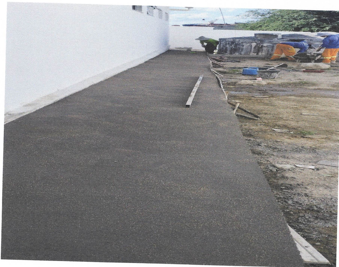
FOTO 05 EXECUÇÃO DE PASSEIO
