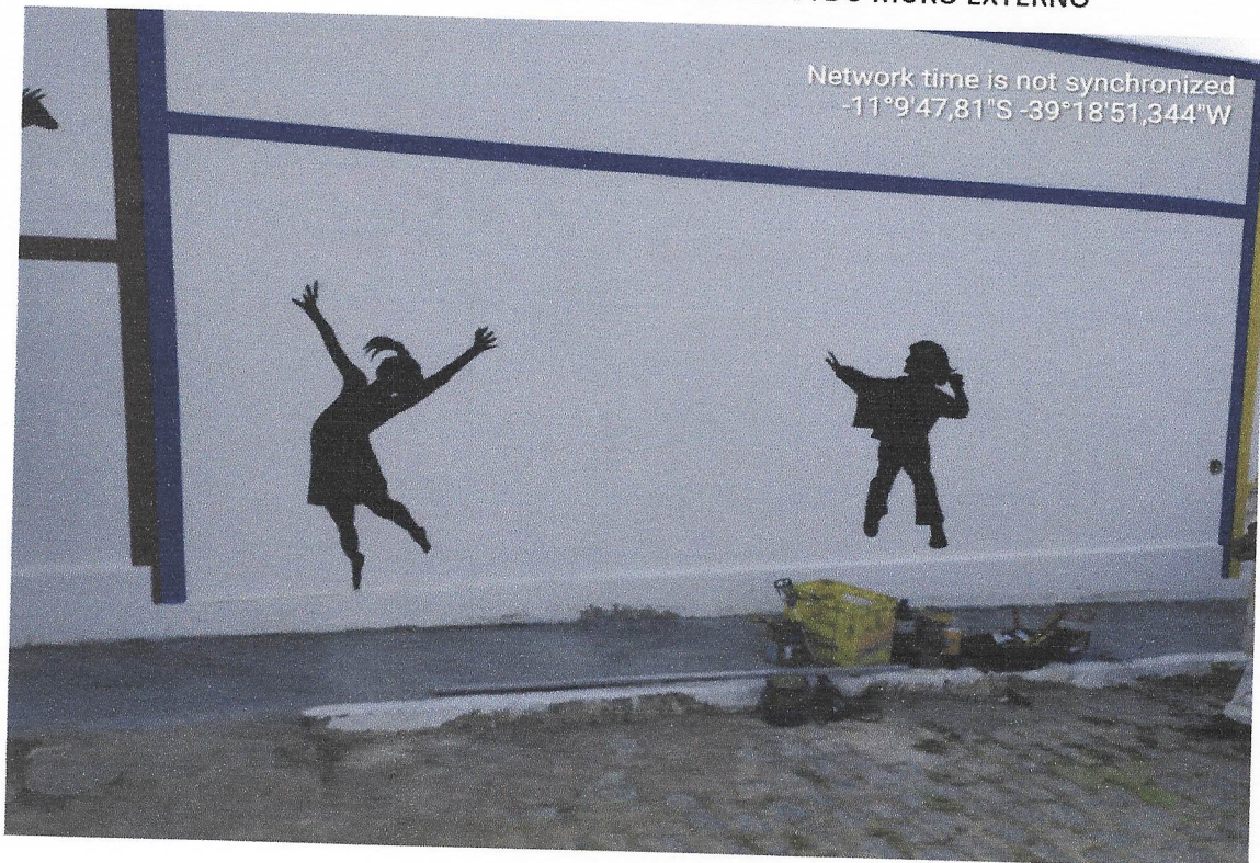
FOTO 24 PINTURA EXECUÇÃO DE ARTE NA PINTURA DO MURO EXTERNO
