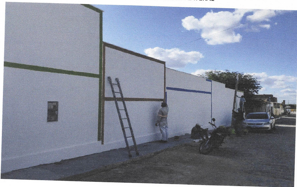
FOTO 22 PINTURA DE FAIXADA LATERAL
